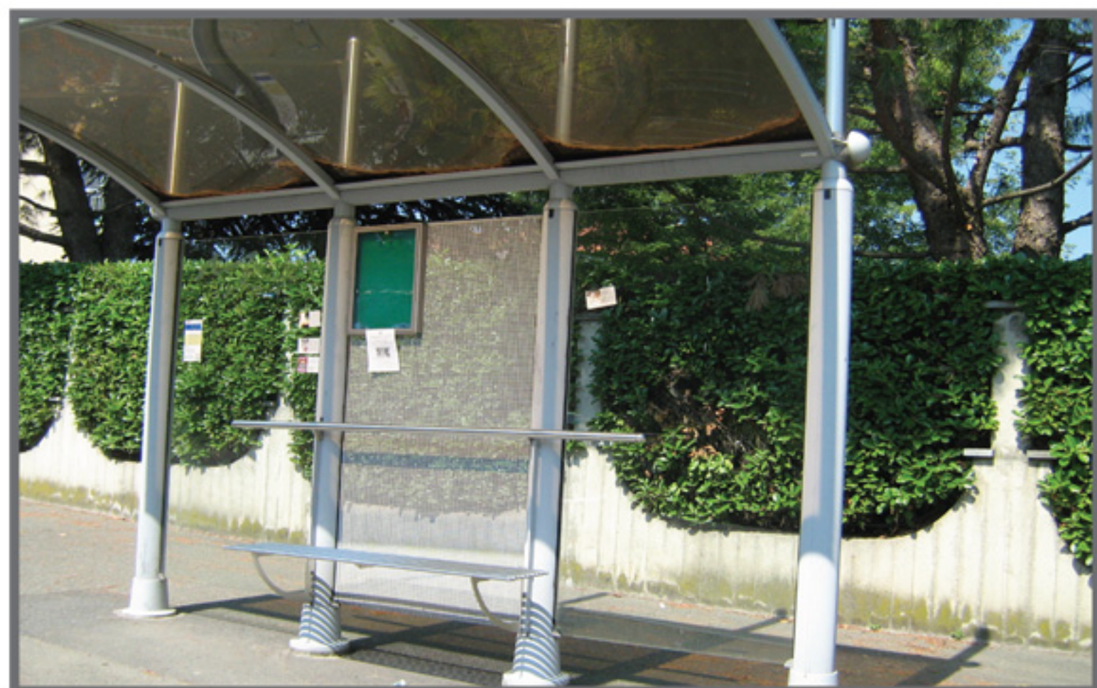
Rivoli, pensilina in Corso De Gasperi. Prima e dopo la posa in opera.
